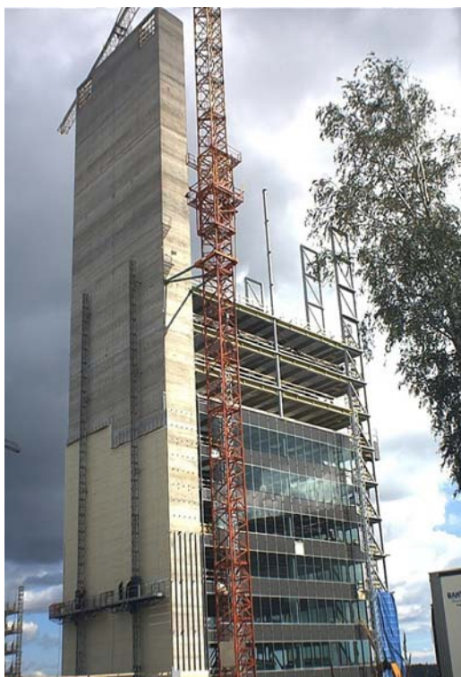
Kuva 2. Jäykistävä torni valmis, tasojen rakentaminen käynnissä.
