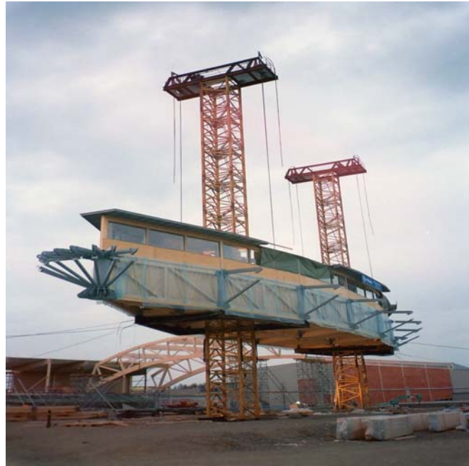
Kuva 7 Asennustilanne ja tukirakenteen liitos
