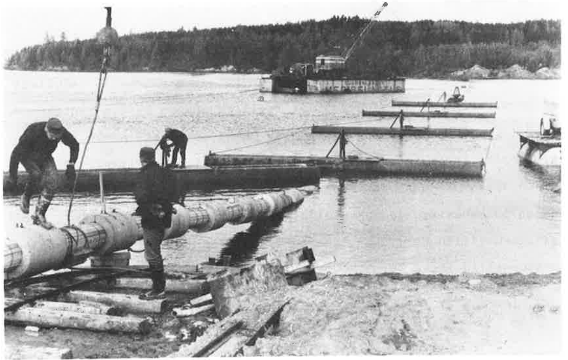
Kuva 7. Valmiiksi rakennettua ja painotettua kaasuputkea kiinnitetään ponttooneihin Vuoksen rannassa
