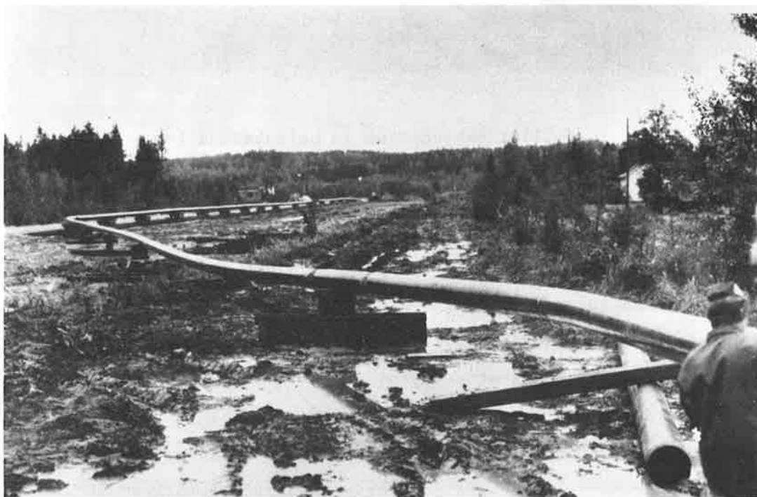
Kuva 6. Pohjan muotoiseksi tehty kaasuputki odottamassa eristystä ja painotusta
